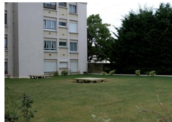
NOVASPHALTE® en étanchéité de toiture terrasse jardin
