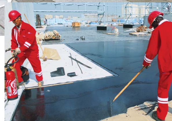
Mise en œuvre du NOVASPHALTE® avant pose de l'isolant
