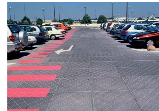
Etanchéité de terrasses parkings isolées avec le système PARDAK® 90
